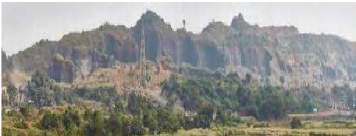
Fig-6: Actual Site Photograph
